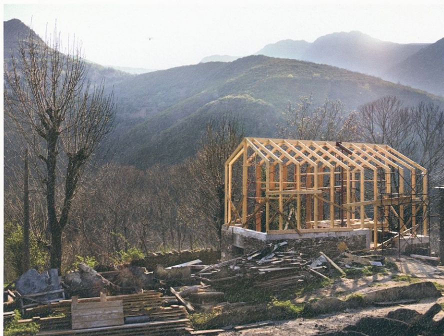
Construcción. Estructura de madera sobre el muro de piedra original. Construction. Timber structure on the original stone wall.
