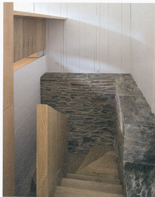
Escalera de acceso a la primera planta donde se aprecia el paso del muro de piedra a la pared de madera. El Courel desde el interior del edificio. Access staircase to the first floor where the transition from the stone wall to the wood one can be appreciated.
